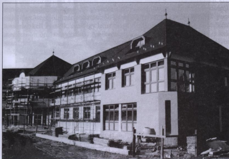
Állványozzák a homlokzatot
